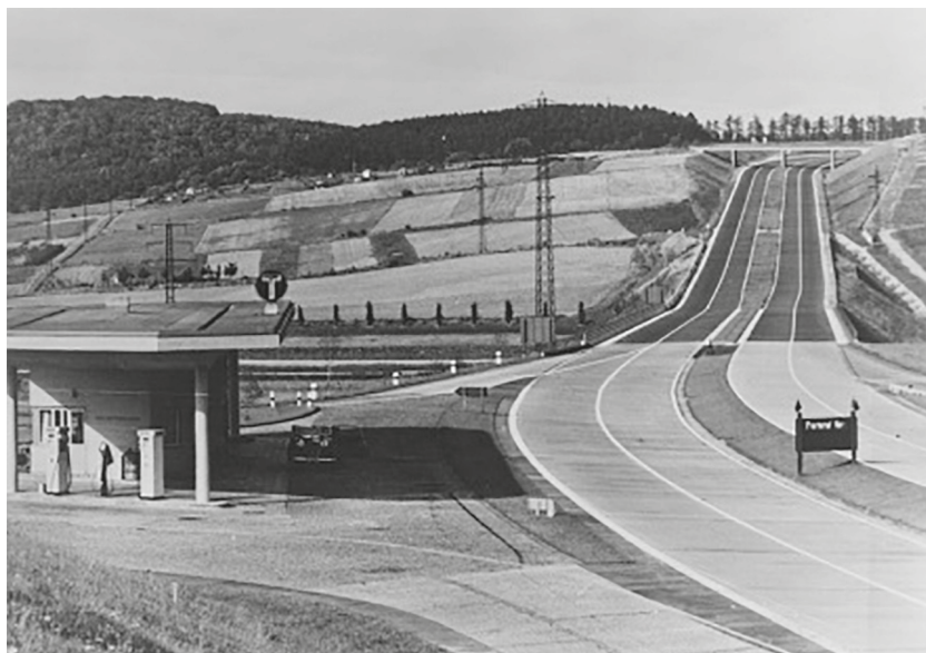
Ryc. 4. Trasa dwujezdniowa Reichsautobahn wraz ze stacją benzynową.
